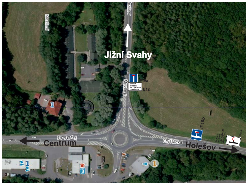
KRUHÁČ - ČERPACÍ STANICE SCHELL
