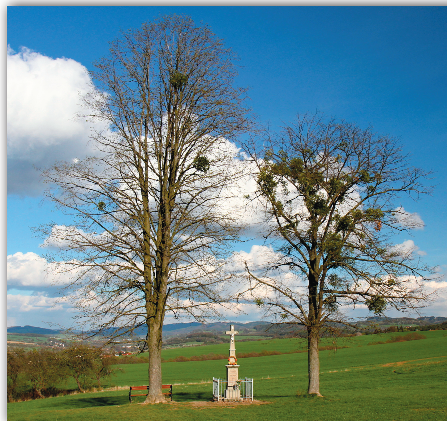
Celkový pohled po rekonstrukci
