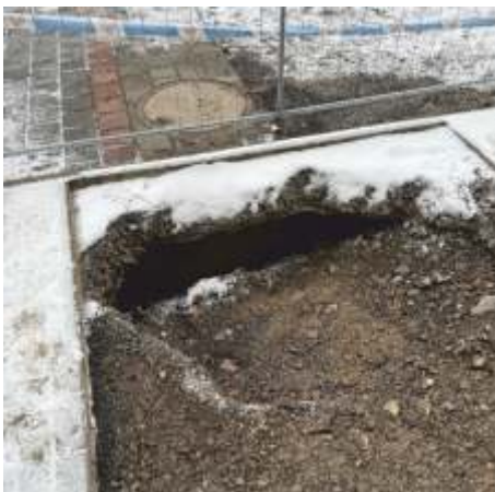
Propadnutý chodník havárie dešťové kanalizace. Při netěsnosti ležaté dešťové kanalizace vymlela voda ze střechy kavernu pod chodníkem a parkovacím místem
