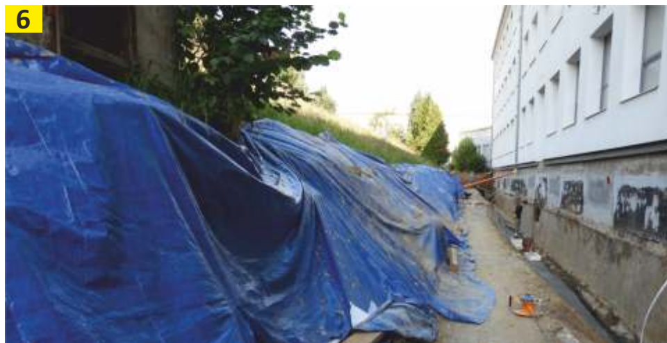
Foto č. 6: zde následují další hloubkové výkopy pro odstranění zeminy.
