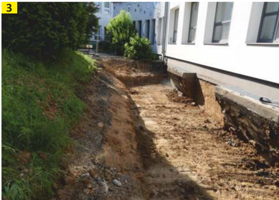
Foto č. 3: začátek výkopu.
