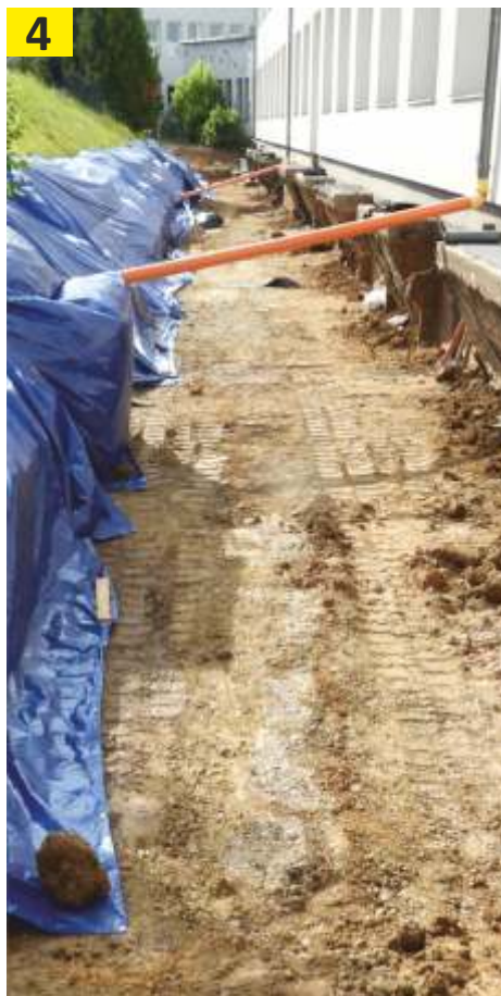
Foto č. 4: pokračující výkopové práce na odstranění zeminy.
