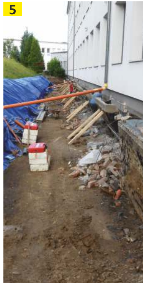
Foto č. 5: zajištění anglických dvorců před jejich odstraněním, které měly velký vliv na pronikání vody.
