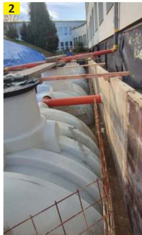
Foto č. 2: instalační práce, napojení vody.
