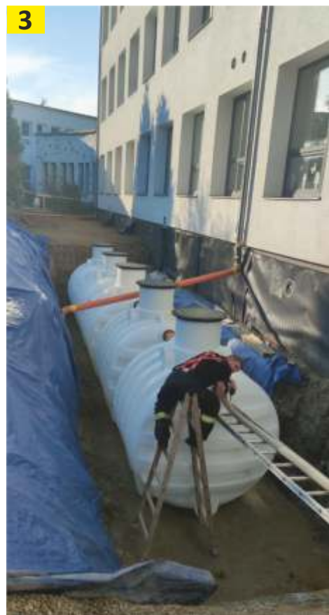
Foto č. 3: hasiči napouštějí vodu na stabilitu nádrže při betonáži.
