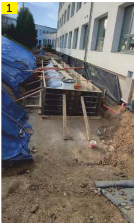
Foto č. 1: bednění přichystané na obetonování nádrže.
