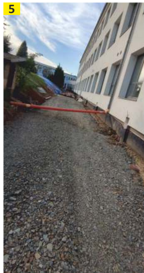
Foto č. 5: zpevňování terénu do původního stavu po izolačních pracích. Staňa Pištěk, zastupitel
