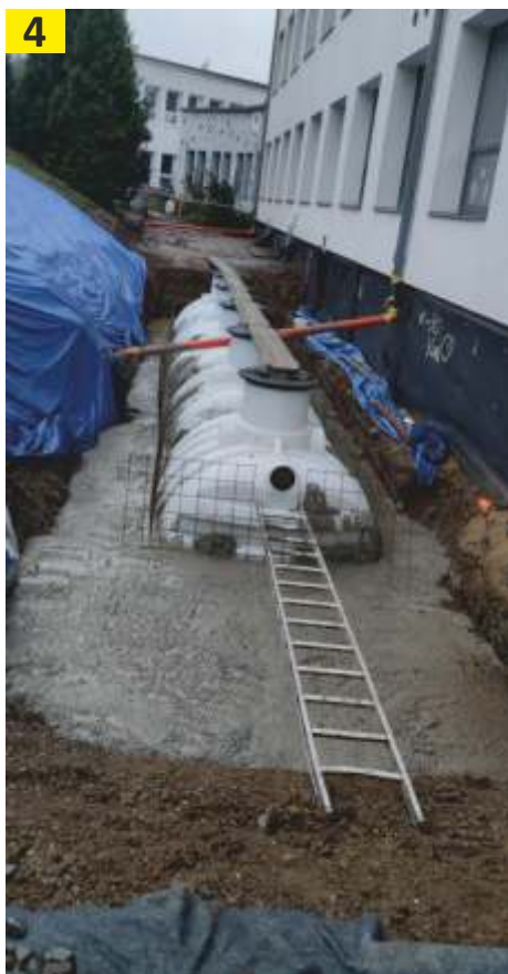
Foto č. 4: postupné obetonování nádrže.
